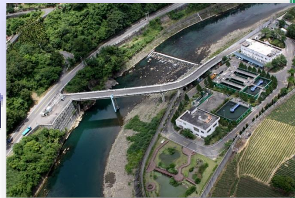
興建污水處理廠 + 衛生下水道
