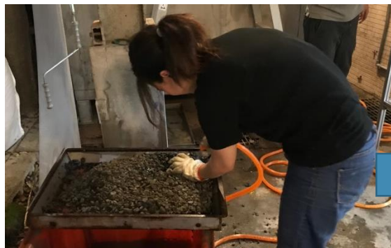
1. 清洗粗石/填底部粗石層
