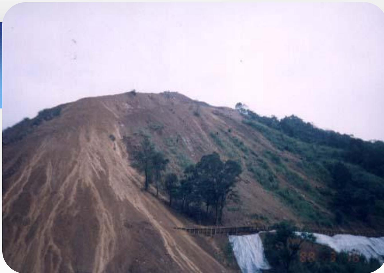
工程施工造成山坡地裸露，且未合理掩蓋，造成大量泥砂流入水體
