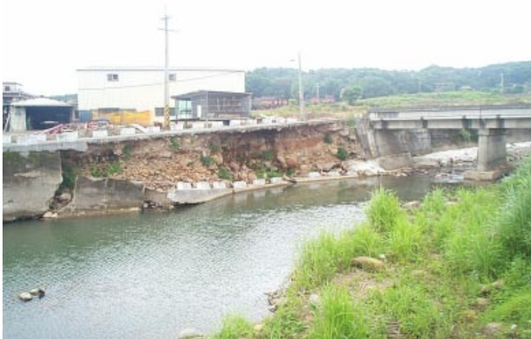
集錦圖 7 淡水大屯溪中游段部分堤岸崩塌
