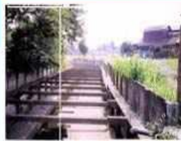
【丸の内線 新豊池（前橋区）】
