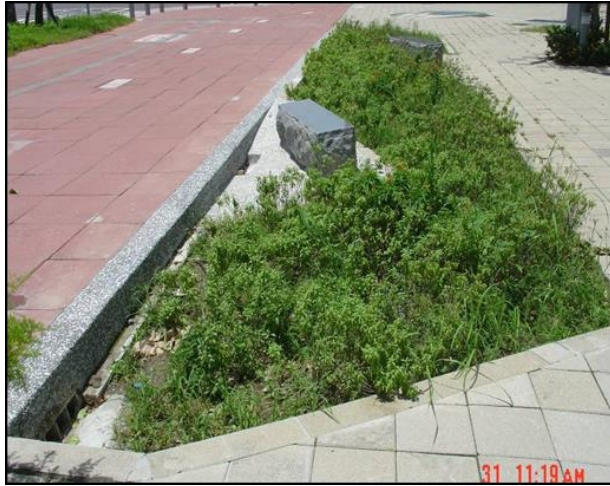
案例一：高雄市博愛路三段捷運生態園區，寬度約120cm 目的：處理道路逕流雨水
