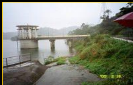
【野溪蝕溝治理】
