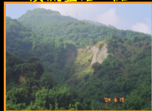
崩塌地處理15點
