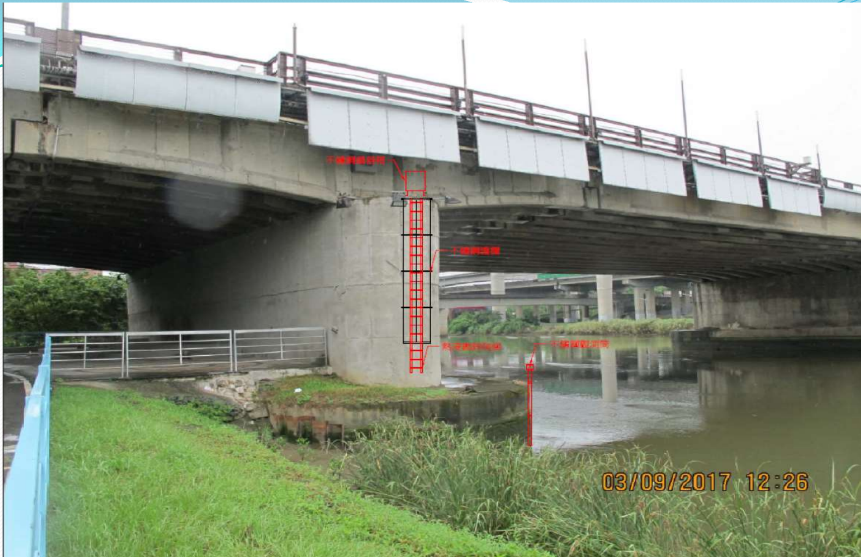
承德橋測站，以3G方式作為數據傳輸網路 但電力供給是個考驗，還有氣候因素考驗
