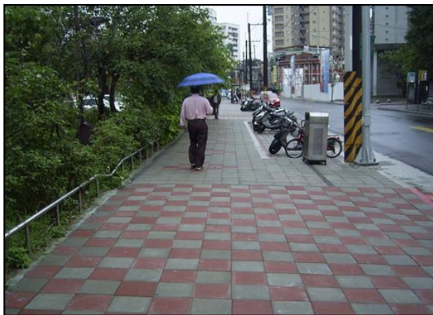
案例一(透水磚)：台北市文山區行政中心周邊人行道，總長300m，寬度4.8m，累積雨量小於30mm，入滲率可達80%
