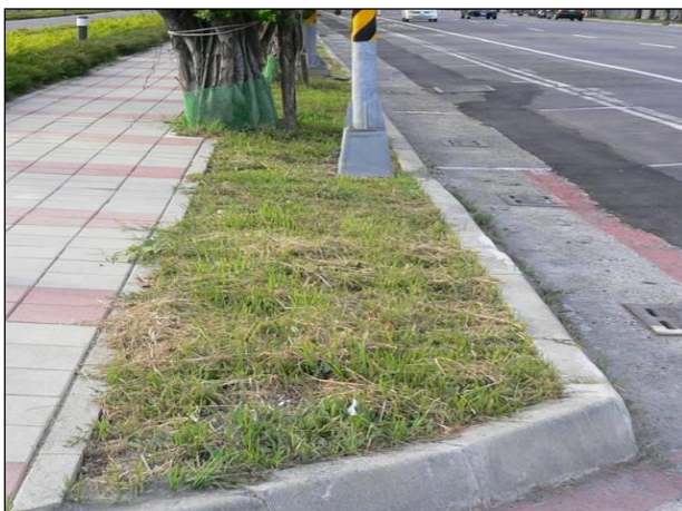
案例一：高雄市博愛路三段捷運生態園區，寬度約120cm 目的：處理道路逕流雨水
