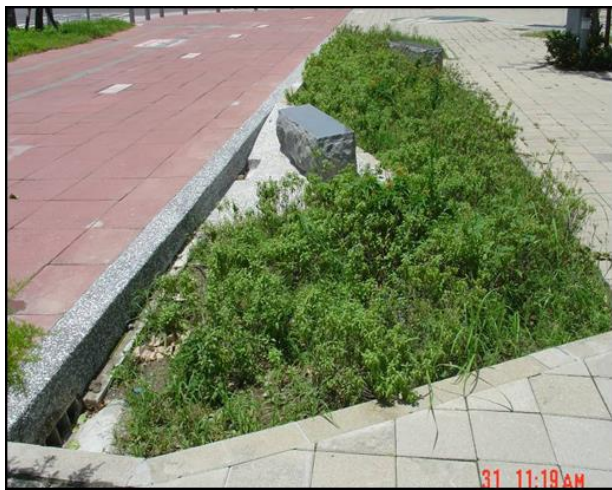
案例一：高雄市博愛路三段捷運生態園區，寬度約120cm 目的：處理道路逕流雨水
