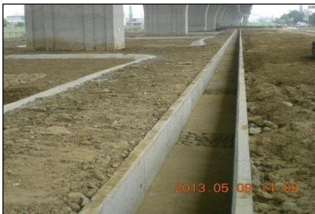
案例一(礫石溝)：台中生活圈2號 線環中路高架橋工程
