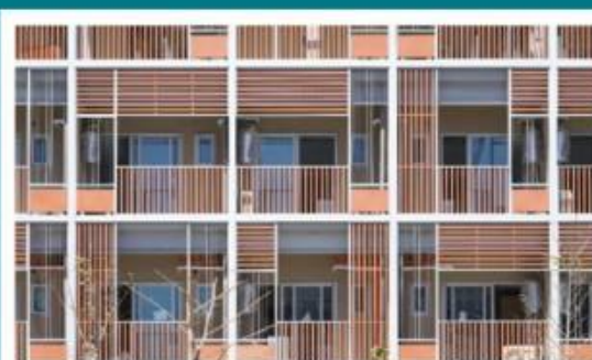
乾式施工及深遮簷設計
