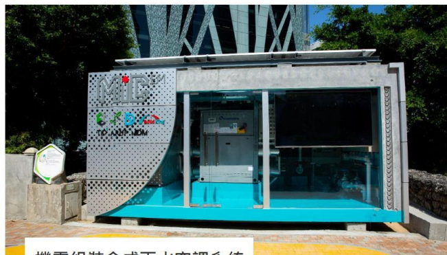
機電組裝合成雨水空調系統
