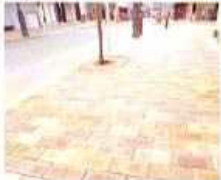
透水性アイル舗装 ●雨水も地面にしりこませる工夫がされたアイルをいいます。
