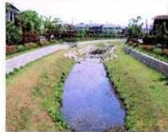
河川改修 (野村、新小金井町) 河川改修
