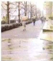
雨水貯留池 ●雨水をそのままだめにしりこませる舗装です。平野から上りの建設です。
