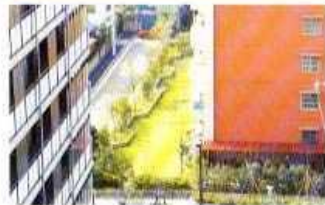
緑屋貯留 (足立区) ●アパートやビルなどの床下を少し高くして、雨水をためておく工夫をしています。
