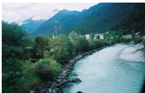
圖四十四 奧地利（作者攝） 護岸基腳拋石小丁壩造成沙堆
