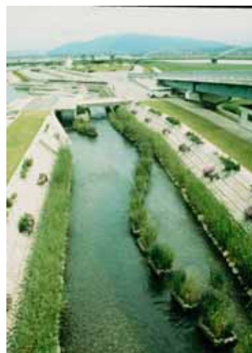
圖二十八 長野縣—小武川（作者攝） 圖二十九 長良川（林信輝教授提供） 整流工程之溪床，用人工拋石塑造棲地 長良川之魚類避難地
