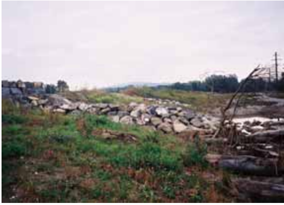
圖五十八 Limada 河（作者攝） 丁壩拋石溢流型
