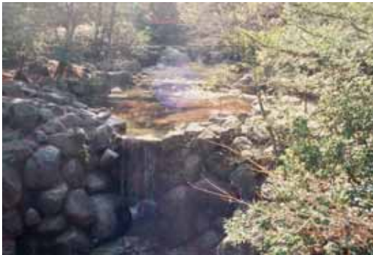
圖二十六 廣島—宮原島(一)(作者攝) 圖二十七 廣島—宮原島(二)(作者攝) 仿自然溪溝防砂壩
