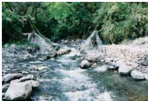
圖十三 高山溪四號防砂壩拆除
