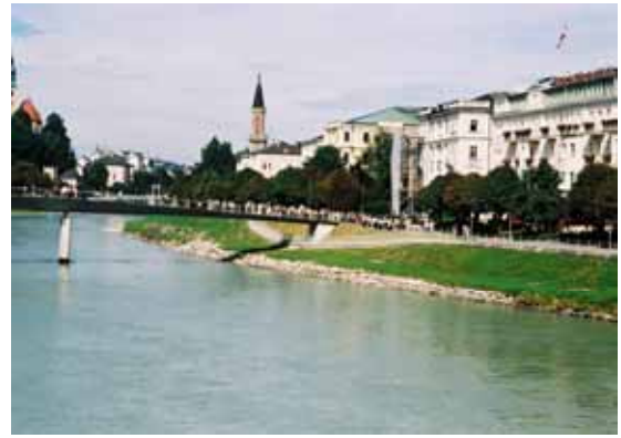
圖五十三 奧地利薩爾斯堡（作者攝） 岩河護岸拋石綠化
