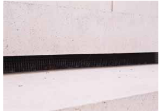
圖五十五 蘇黎世 Limada 河（作者攝） 近市區堤防製造兩生類生物通道
