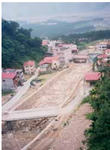
圖五 南投郡坑二廊整流工程
