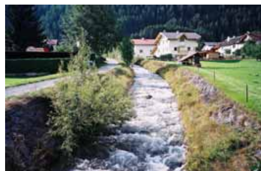
圖四十五 奧地利（作者攝） 整流工程拋石綠化
