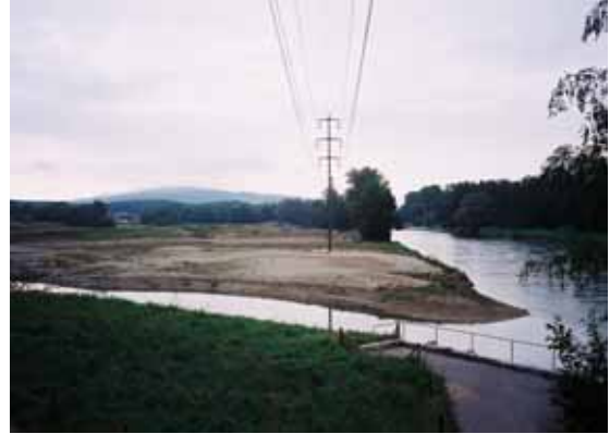
圖五十九 Limada 河（作者攝） 右側為截彎取直之新河道
