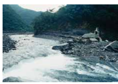
圖十四 高山溪三號防砂壩拆除
