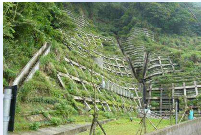
隧道入口邊坡植生
