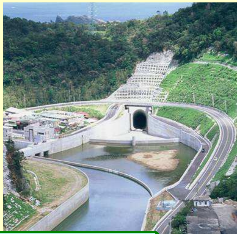
基隆河員山子分洪工程
