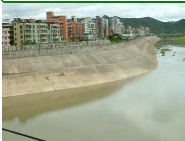
混凝土防洪牆不利生息(基隆河六堵橋)
