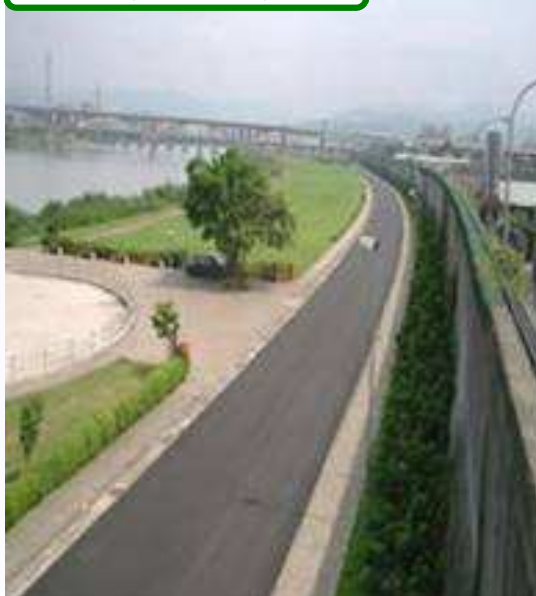
防洪牆及河濱公園
