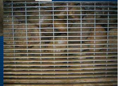
格柵以內即為礫石槽，如下照片 照片右側水泥柱之右側為格柵， 污水經分配水槽後流入礫間淨化槽
