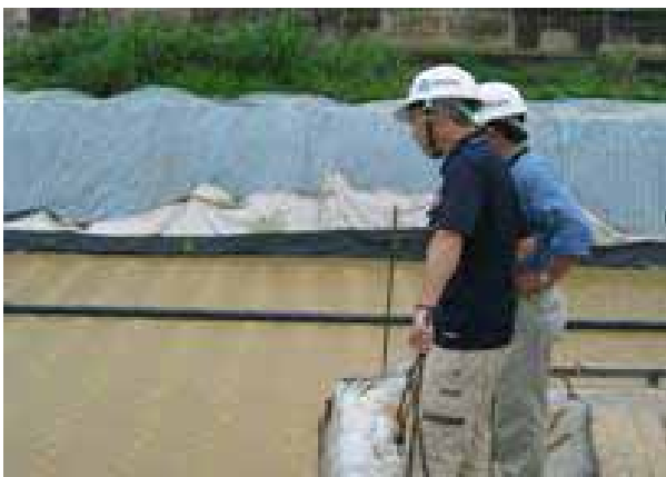
第一次曝氣測試 管線鋪設完成後
