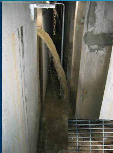
格柵以內即為礫石槽，如下照片 照片右側水泥柱之右側為格柵， 污水經分配水槽後流入礫間淨化槽
