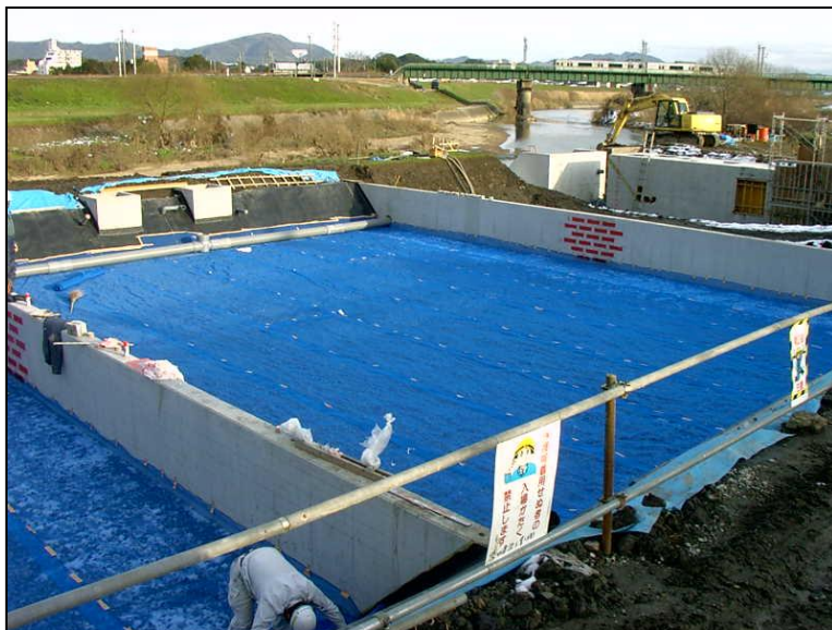
透水シート布設完了 (PEネット2mm目使用)
