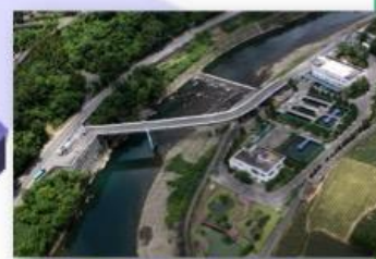
興建污水處理廠 + 衛生下水道
