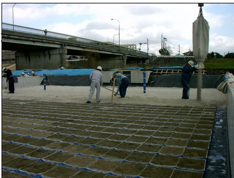
通水層(軽石)投入・敷均し (この時点では粗均しとする。)
