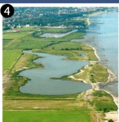
洪氾區滯洪池
