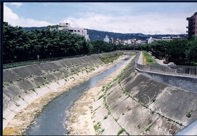
捷運橋以上 已補強 整治中
