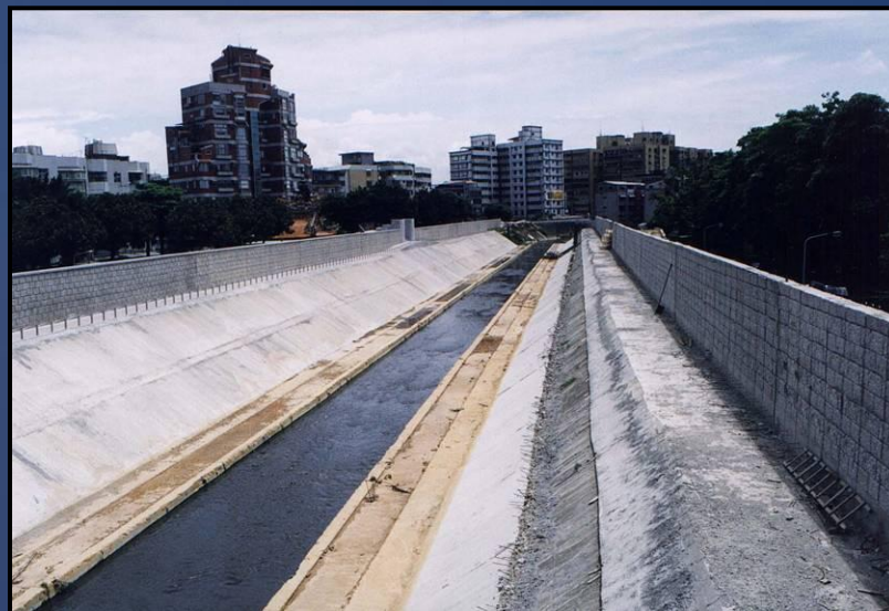
捷運橋下游 完成
