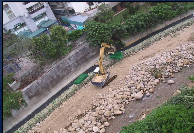
磺溪永和橋間 已補強 分析作業中
