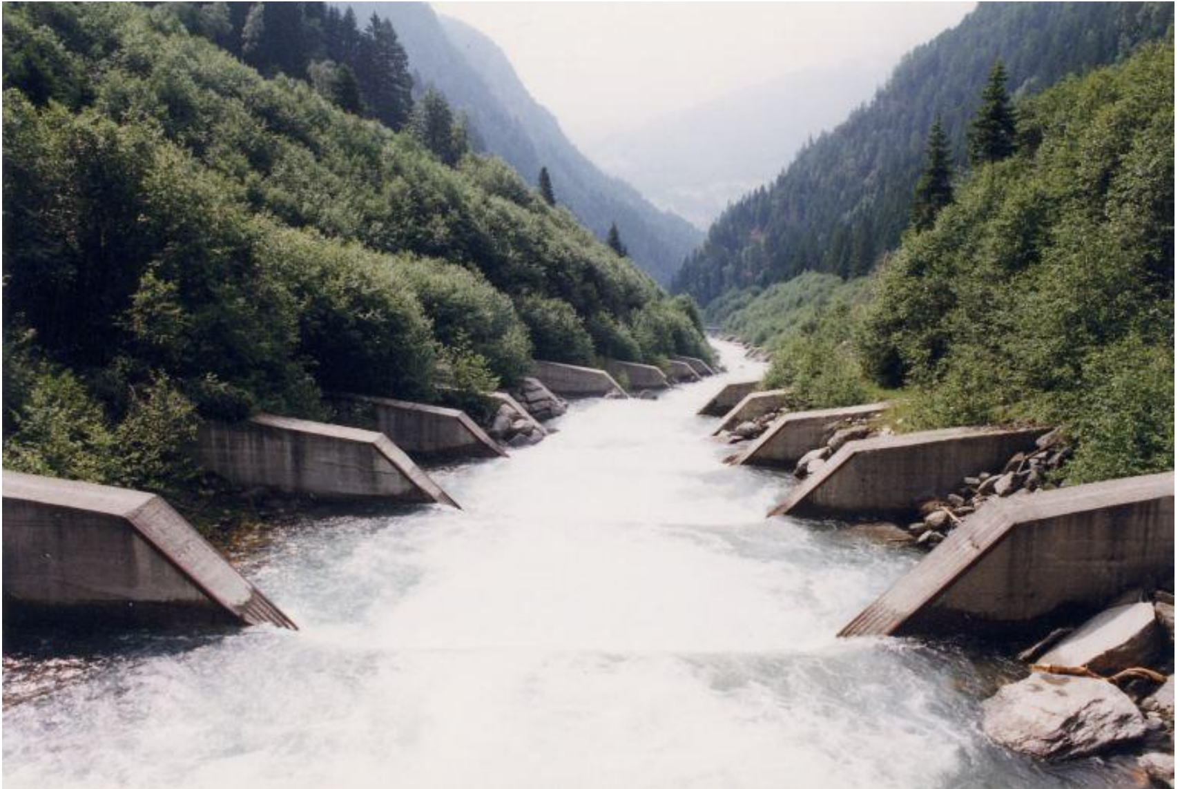
Torrent Control Structure, Weißenbachtal Photo: S. Cantré
