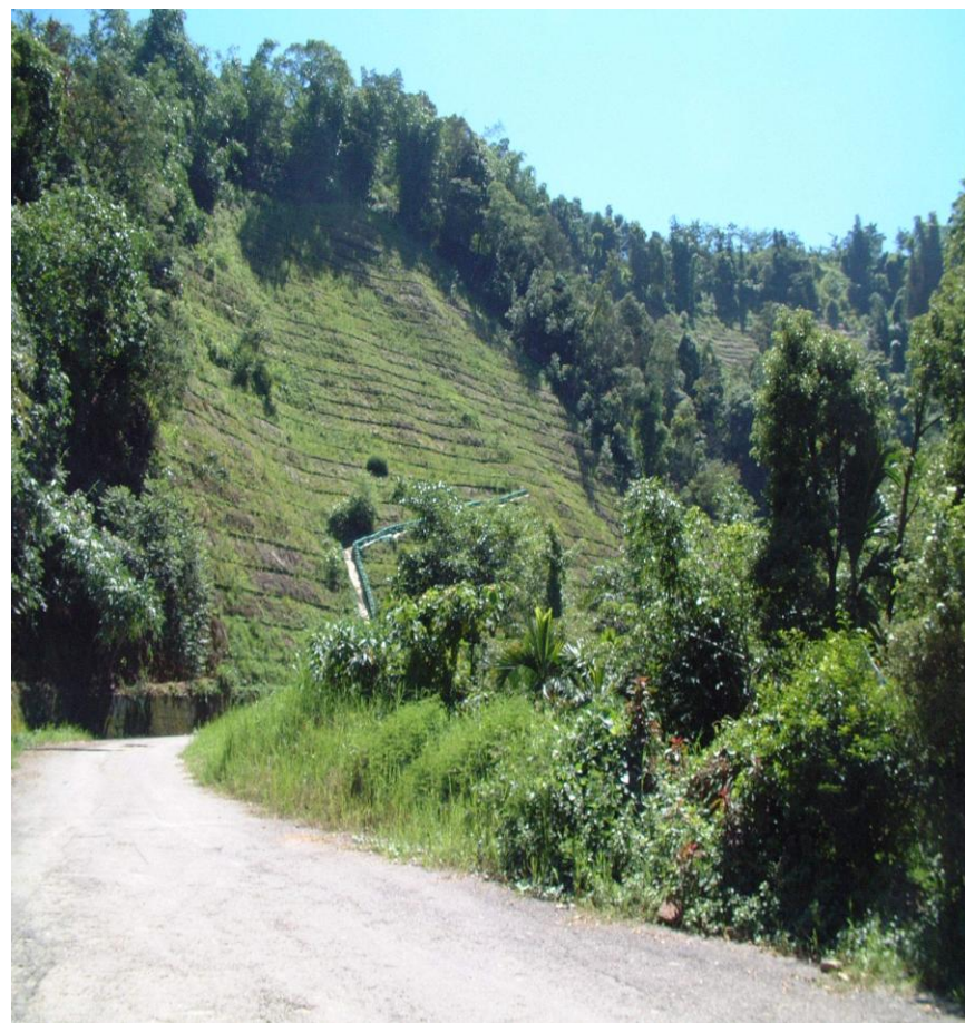
打樁編柵工法維護山坡地生態
