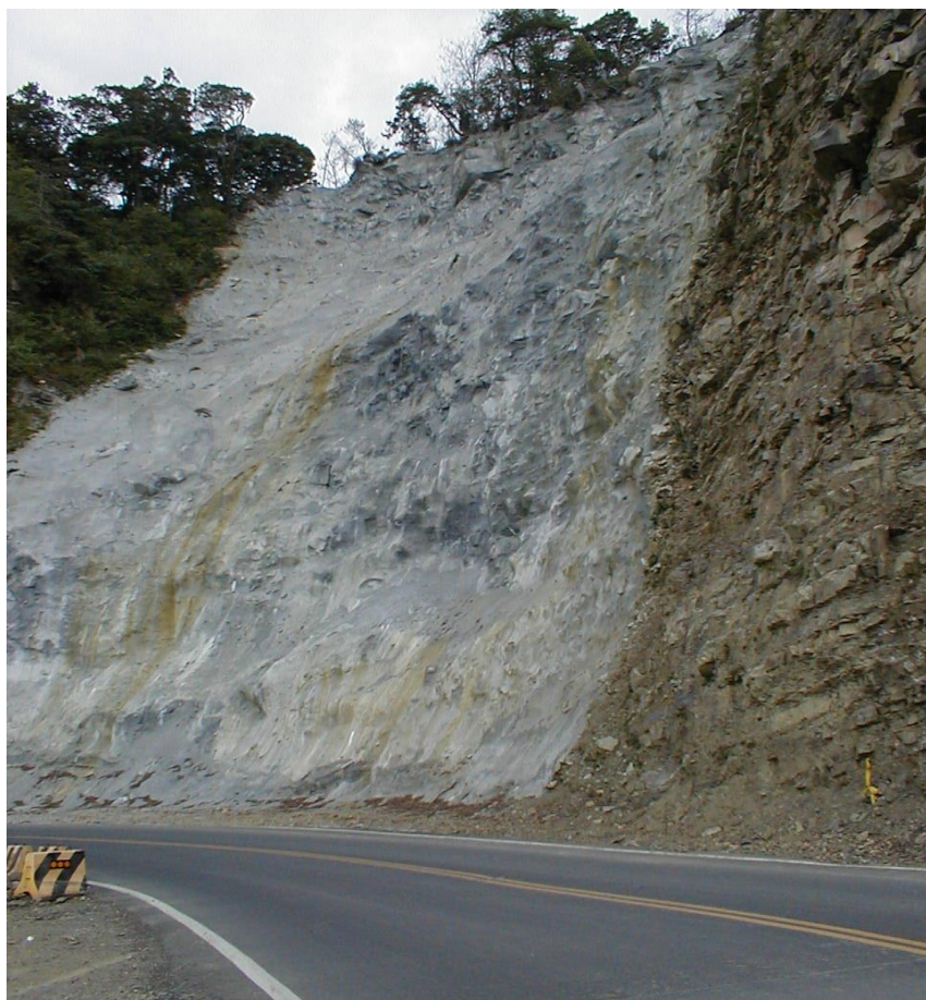
水泥噴漿封殺山坡生態
