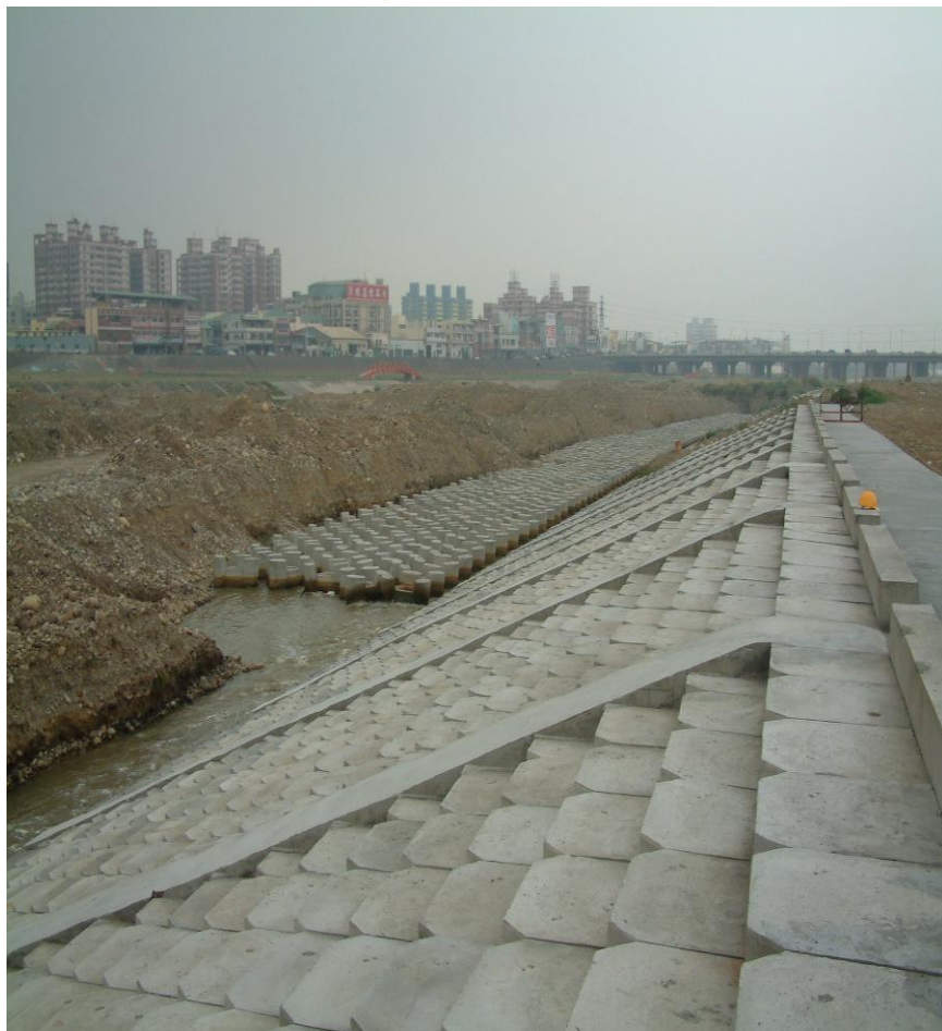
台中市大型束水工程與河爭地
