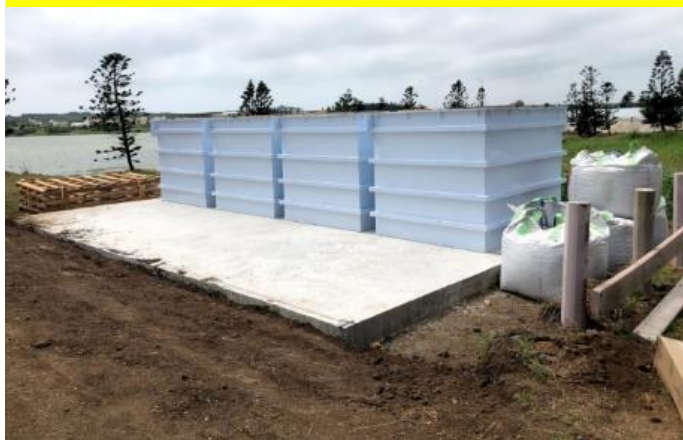
清洗MSL槽體內部
