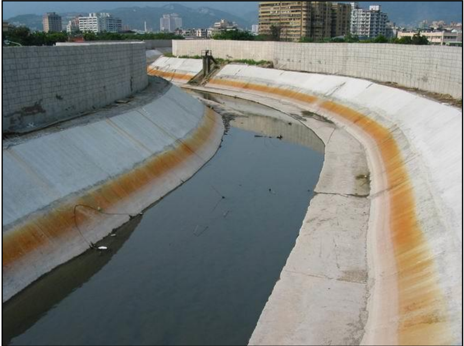
建德橋 91年8月30日
