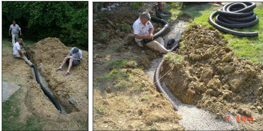
滯水花園-安裝暗渠
