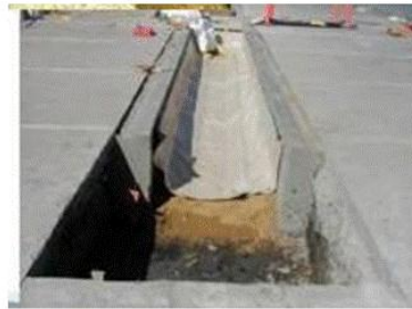
2 裝置基礎層滲濾水道工程
