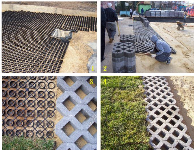
草坪和混凝土透水聯鎖鋪面材料系統的裝設過程
