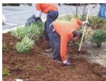
4 於腐土層覆土造景
