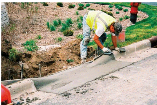
降低路緣，讓道路上的雨水能進入設施。
