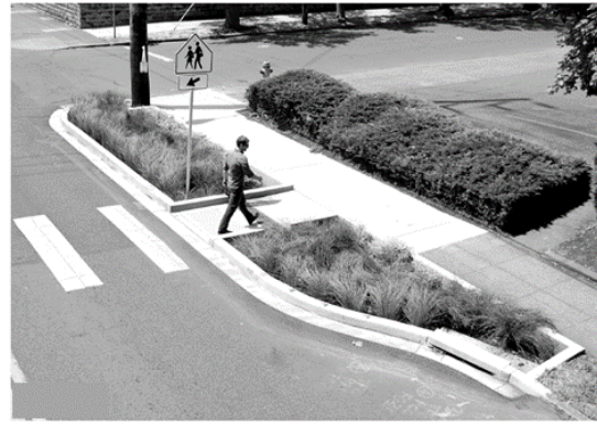
設置於路口的加寬型路緣綠街道，讓汽車停放空間離開此範圍，提高行人的安全，同時提高了駕駛者和行人的視線。
