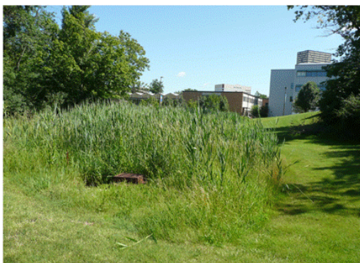
滯洪池與出口結構的前視照
