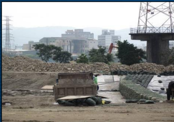
植栽浸潤床處理單元卵石現地採取
