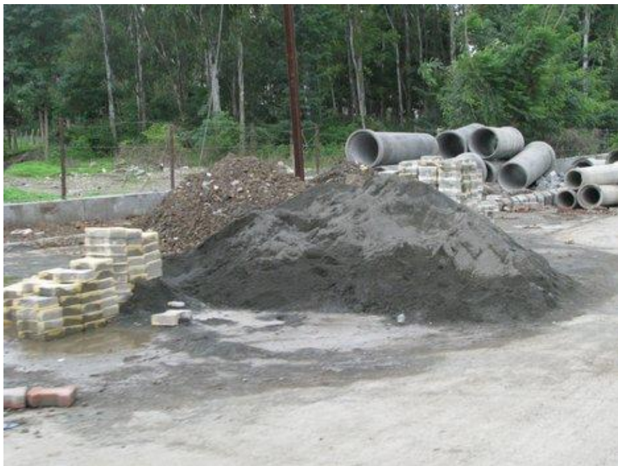
施工材料堆置
