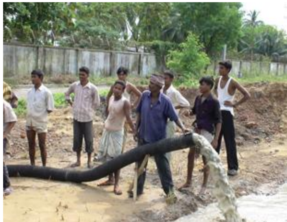
開挖廢水抽排
