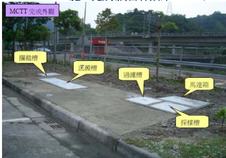
MCTT施工完成(摘自林鎮洋，2007)
