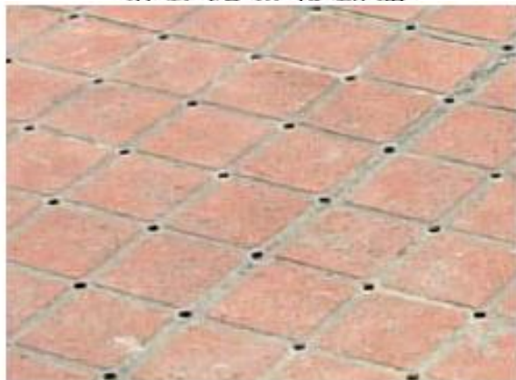
環保透水透氣混凝土鋪面
