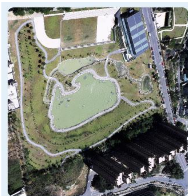
本和里生態滯洪池空照圖。(高雄市政府工務局提供)
