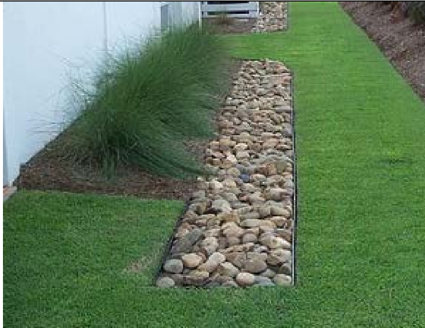
入滲乾井照片
