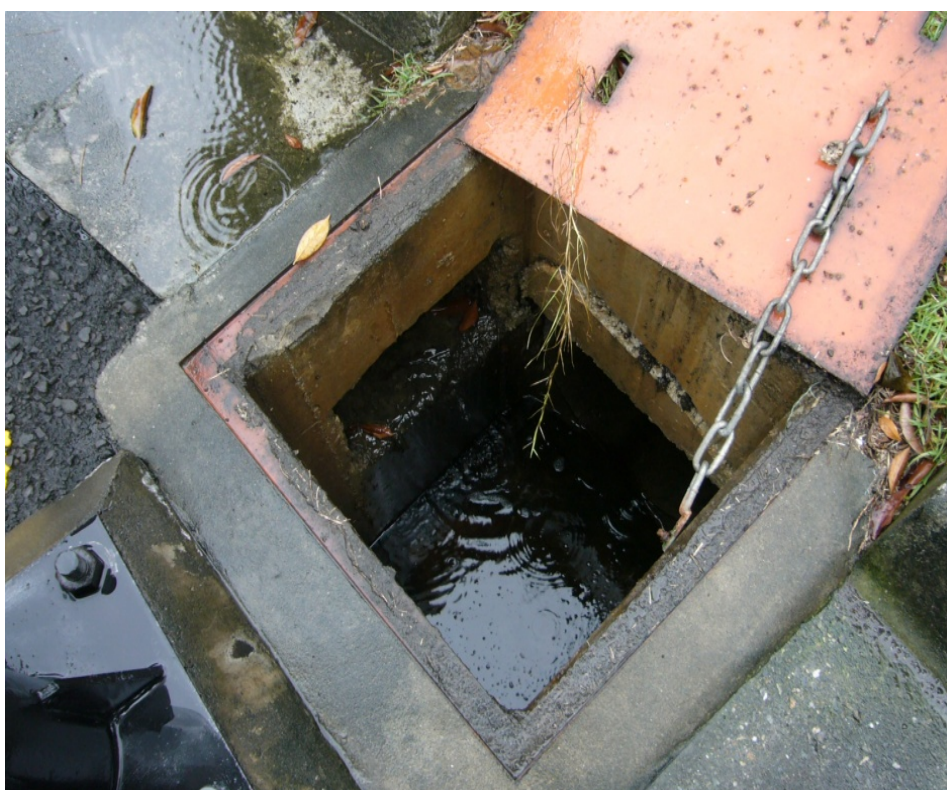
圖 8.2.2 坪林行控中心停車場雨水陰井（可見表面油污）
