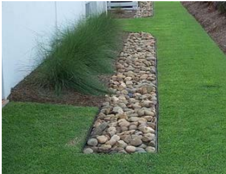
入滲乾井照片
