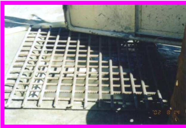
洗車台四周應設置 廢水收集坑
