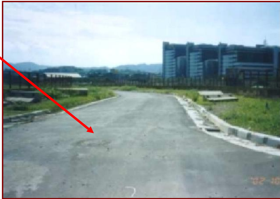
鋪設瀝青混凝土
