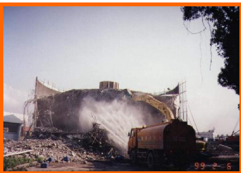
拆除作業進行時，配合加壓噴灑水
