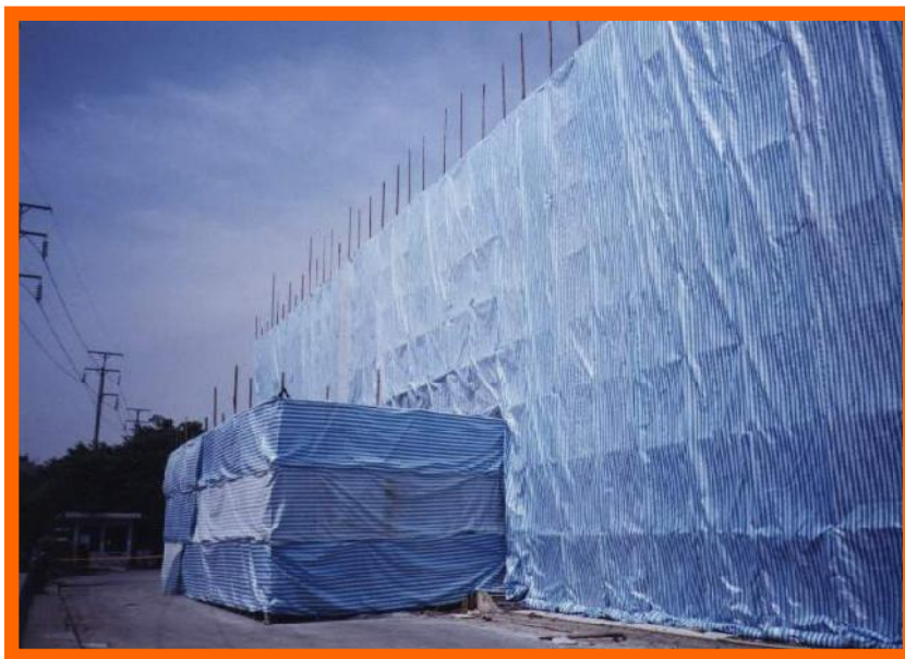
拆除結構體外包覆防塵布
