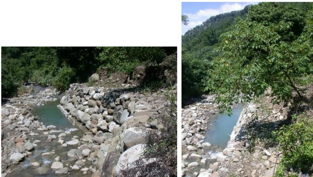
圖 2-56 南化水庫關山村平坑一號壩下游護岸工程施做成果
